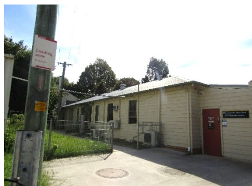
UPCC (Building 75E&F)
